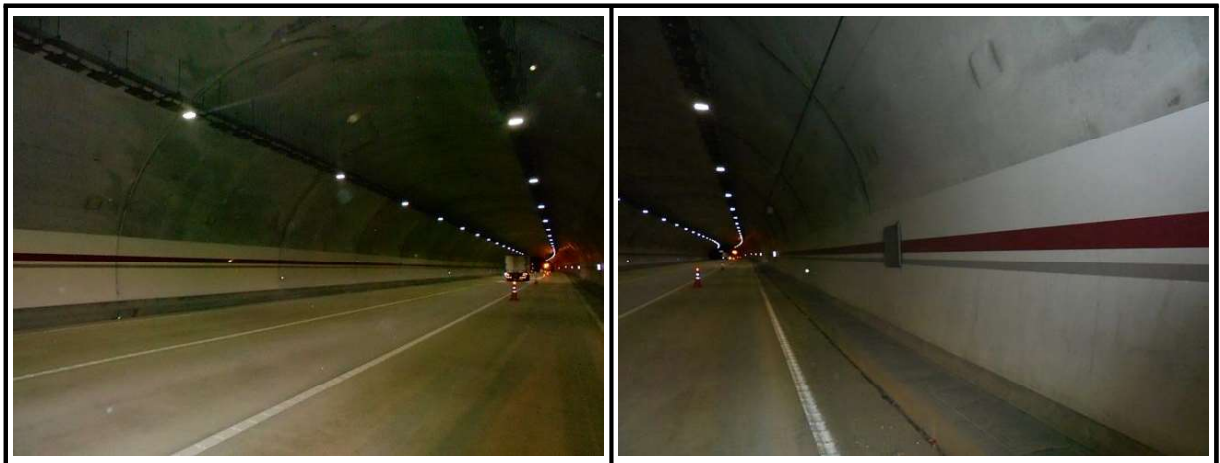
【사진 2.3.16】 라이닝 측벽부 전경
