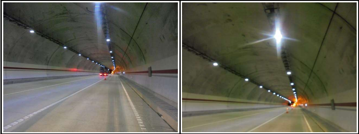
【사진 2.3.14】 라이닝 천단부 전경
