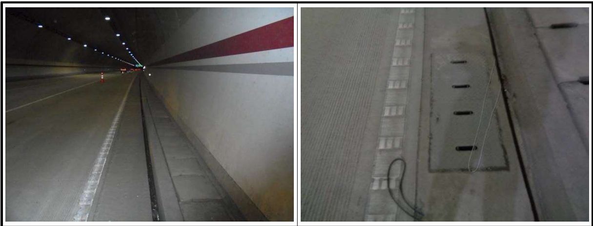
【사진 2.3.8】 공동구 및 배수시설 전경
