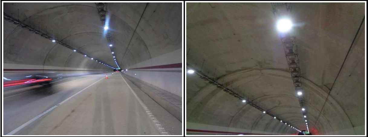
【사진 2.3.1】 라이닝 천단부 전경
