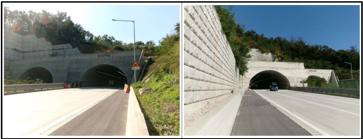
【사진 2.3.5】 갭문 전경
