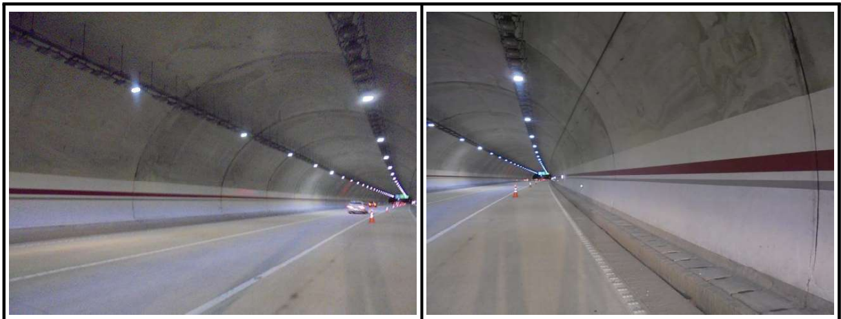
【사진 2.3.3】 라이닝 측벽부 전경
