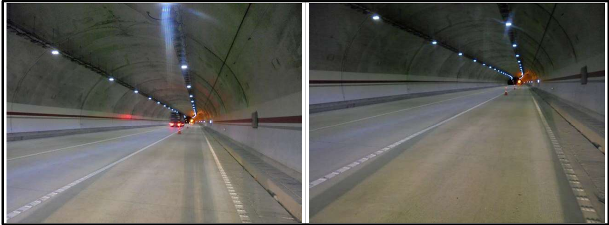
【사진 2.3.23】 포장부 전경
