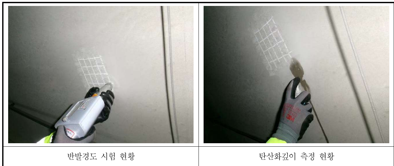
【사진 2.4.1】 콘크리트 내구성조사 현황
