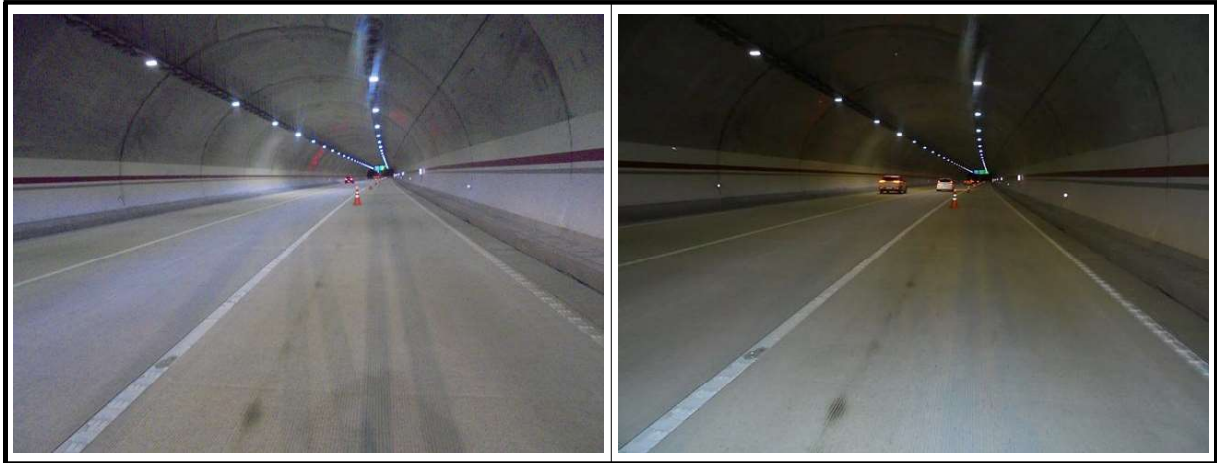
【사진 2.3.10】 포장부 전경
